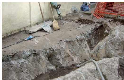
Lavori per il risanamento dall'umidità del complesso di Betlemme
